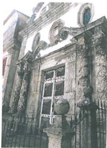
Figura 21- Capela da Misericórdia de Murça Fonte: Coteffis, 2016
