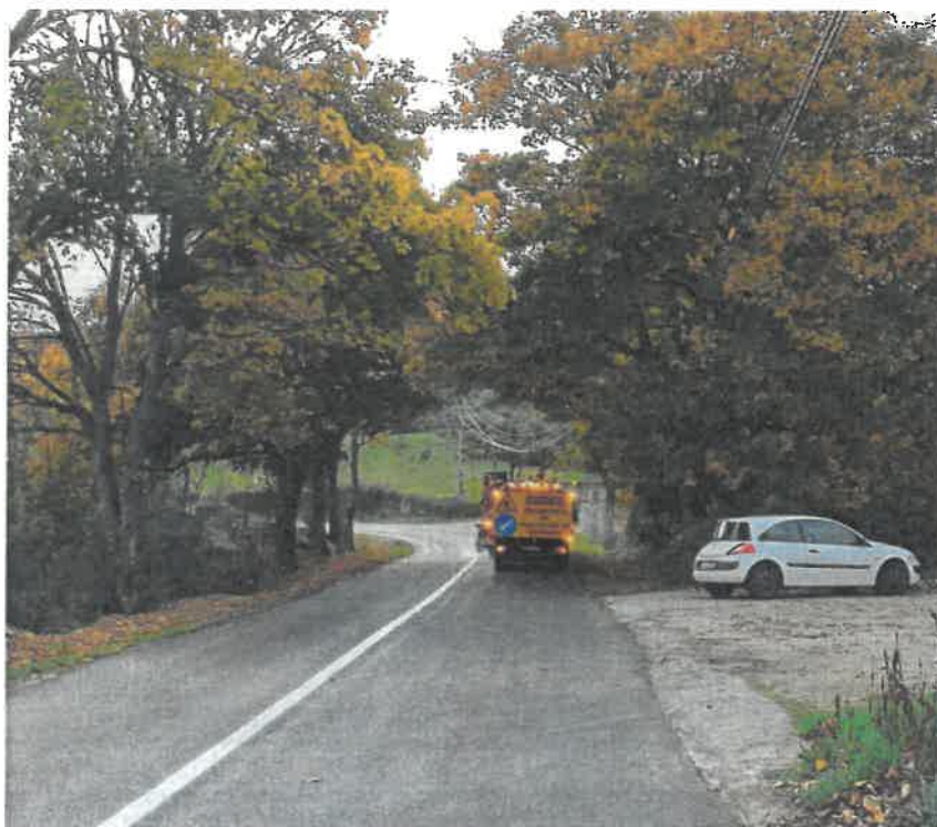
Figura 1- ER314 - Sinalização horizontal ao eixo
