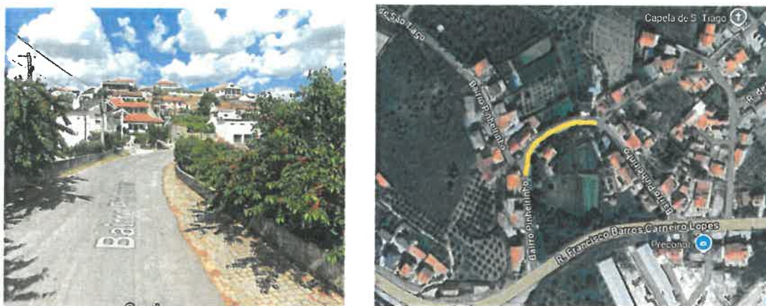
Figura 9 – Local a revestir as bermas com cubo de granito
