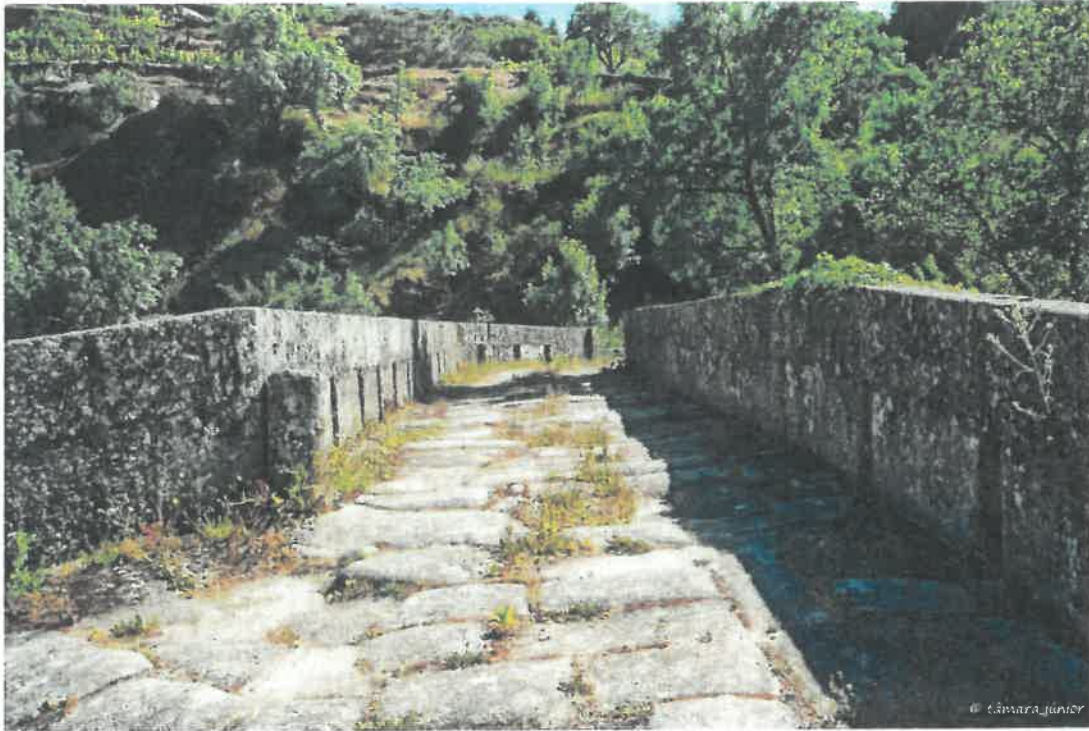
Pontos de Interesse 9 - Ponte e Via Imperial Romana
