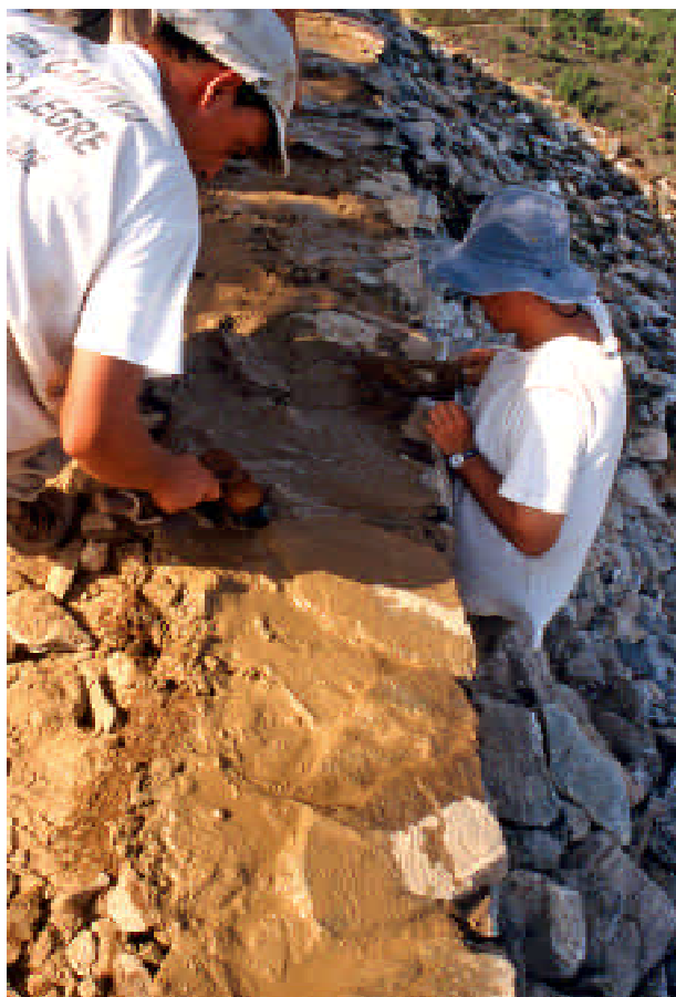
Foto II.21 (2002) Restauro da Muralha do Recinto L
