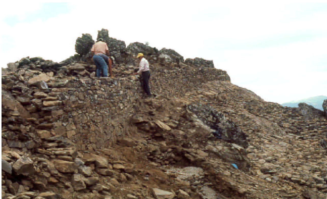
Foto II.20. Aspecto do restauro da Muralha e do Talude Exterior Norte
