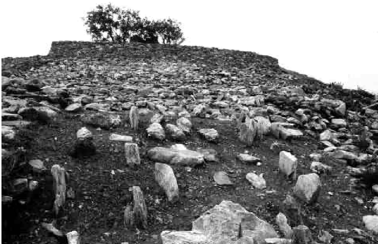
Foto II.34. Talude Exterior Leste e muralha do Recinto L, ambos restaurados. Em primeiro plano, a fachada de blocos fincados.
