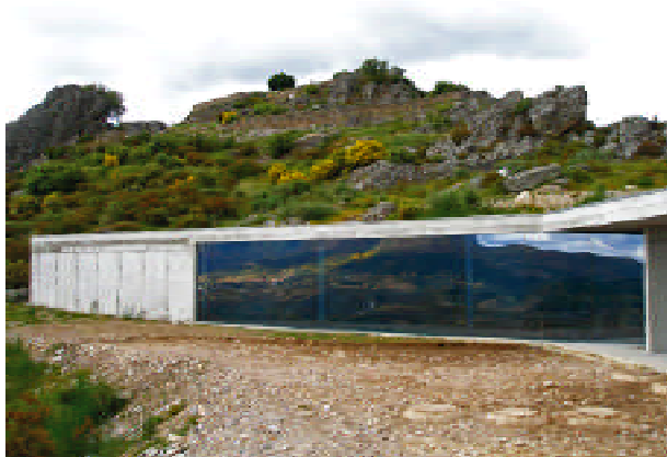
Foto II.23 ( Maio de 2008): Centro Interpretativo no momento em que terminou a sua construção. Repare-se na sua inserção na encosta da estação arqueológica.
