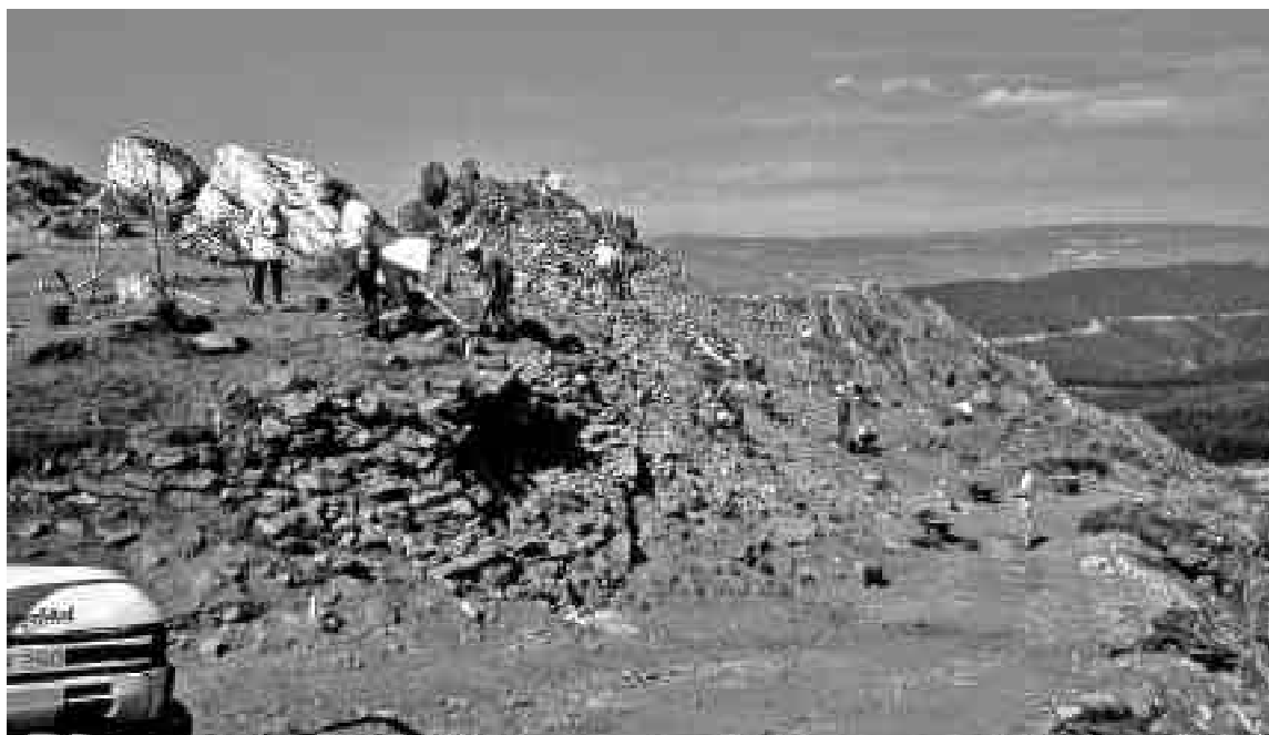
Foto II.18. Início da escavação da Plataforma Inferior Norte, da Muralha e Talude externo Norte. Chama-se a atenção para a destruição que a abertura do estradão e a exploração de pedra provocaram na muralha (de que só se vêem os alicerces) e no Talude.
