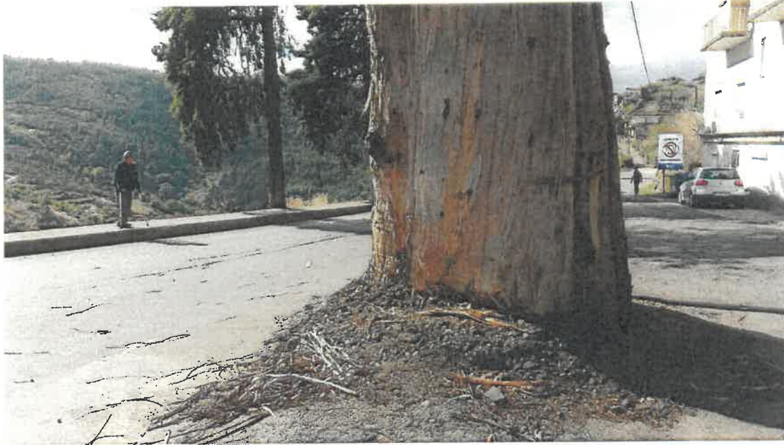
Figura 12 – Impermeabilização total do solo com pavimento betuminoso.
