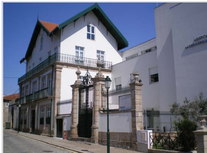
Aspecto do exterior do Hospital de Cuidados Continuados da Santa Casa da Misericórdia de Murça
