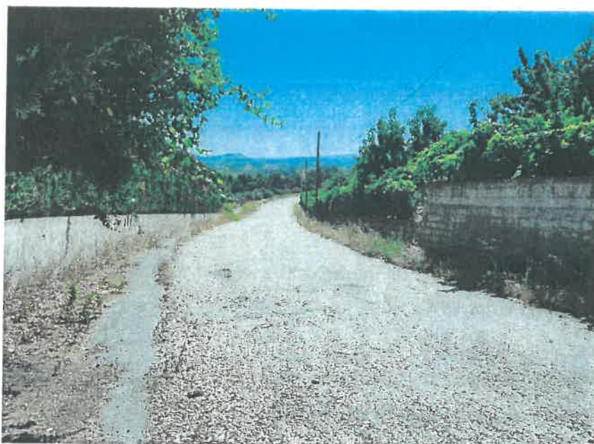
Figura 21 – Plataforma da Rua de S. Miguel.
