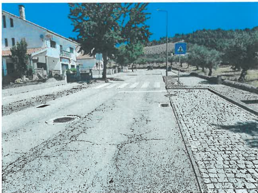
Figura 8 – Fendilhamento longitudinal ramificado com elevada severidade (atravessamento de Murça).
