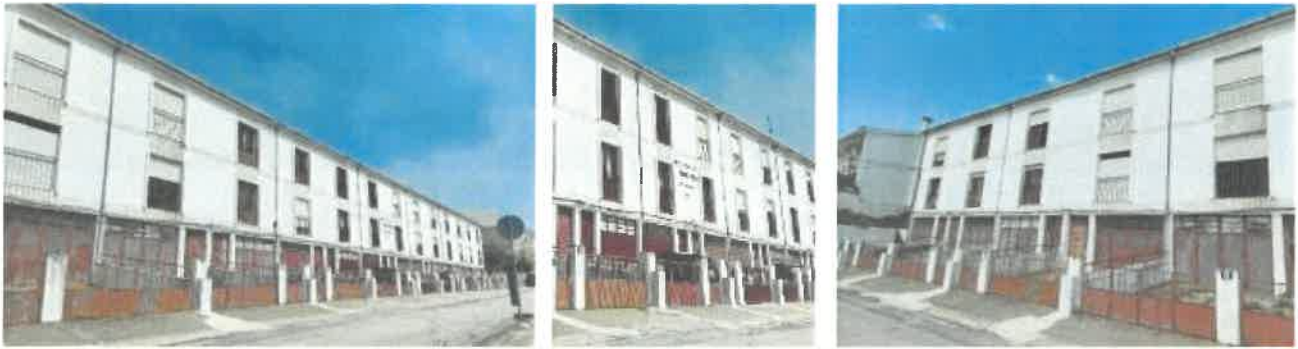
Figura 15. Edifício da Santa Casa de Misericórdia
